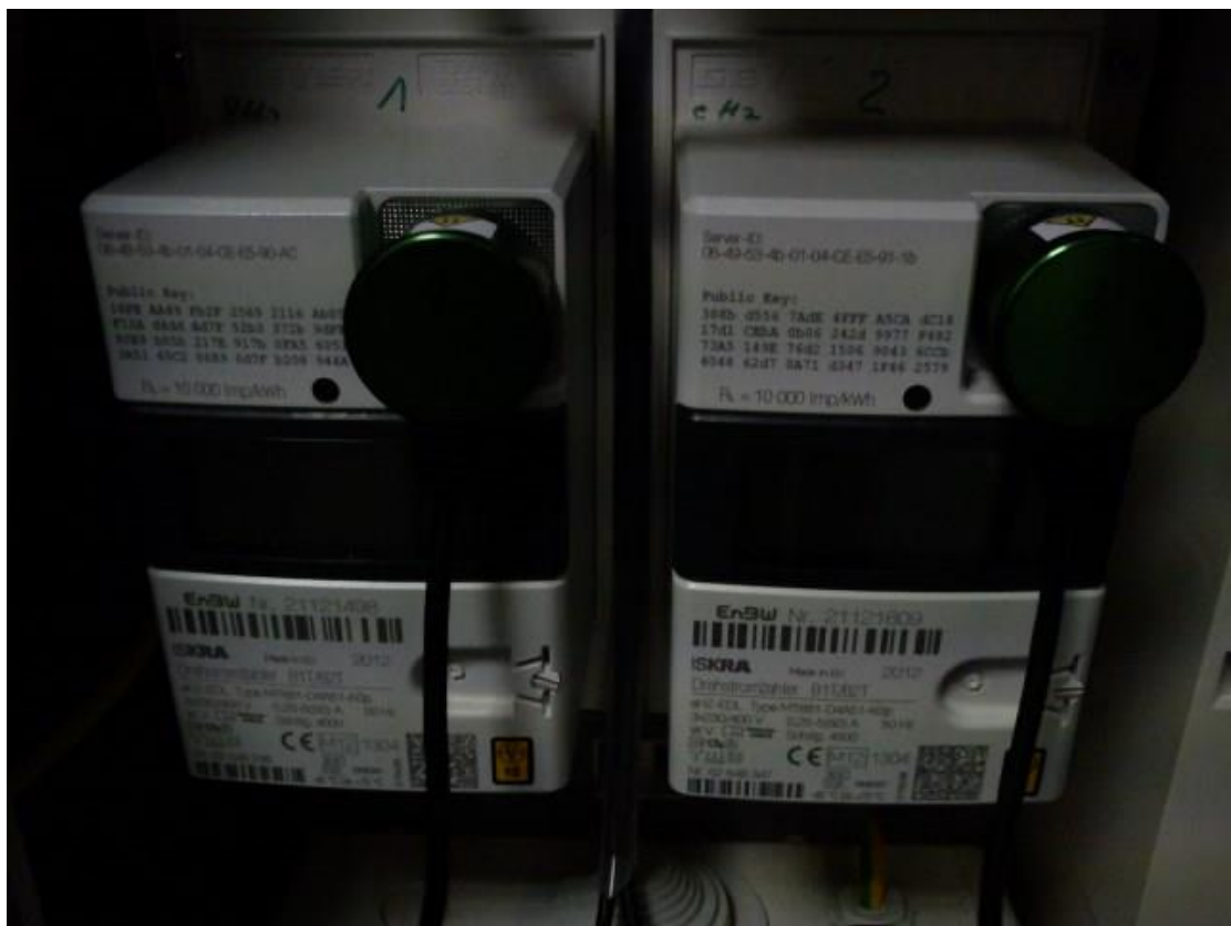
Abbildung 1 Zwei eHz mit optischem Tastkopf vorn, magnetisch fixiert
